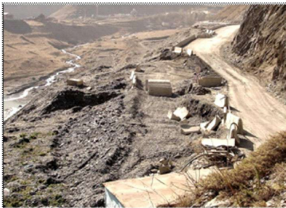
Рис. 1. Обходная дорога в Мамисонском ущелье от южного портала до р. Адайком.
