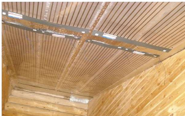
Рис. 3. Общая пленочная система отопления потолка.
