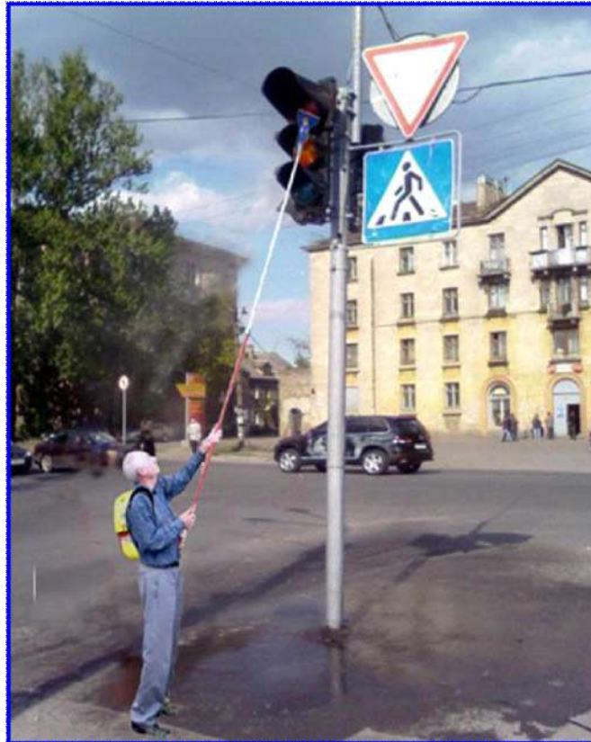
Рисунок . Устройство для очистки поверхностей в работе
