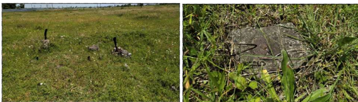
Рисунок 2. Пункт ГГС «Фарн» в 522 м от с. Фарн (а – внутренний знак найден; б – внешний знак поврежден).
