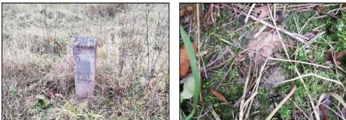
Рисунок 2 – Оповестительный столб пункта ГГС «Алагир» (а) и состояние марки (б)
