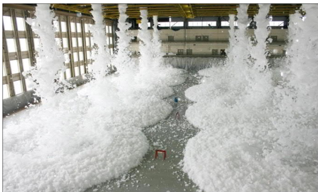
Рис. 4. Спринклерная установка пожаротушения.
